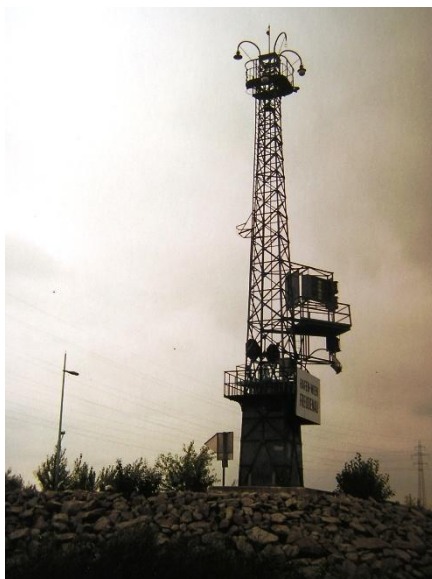
Neues und altes Donau-Leuchtzeichen AT0005. Foto rechts: der alte 20m Turm aus dem Jahre 1905, hier aus 2001
