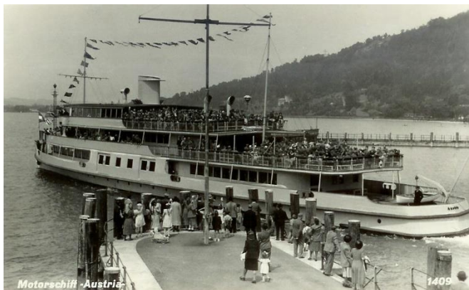
Foto oben zeigt M/S AUSTRIA in Bregenz 1950 und rechts mit OE6NFK im Hafen von Bregenz im Februar 2025. M/S AUSTRIA, Bj. 1939, Schiffswerft Korneuburg/Donau, 60m lg., 458t, 1.492PS, 32km/h, 1.200 Personen.
